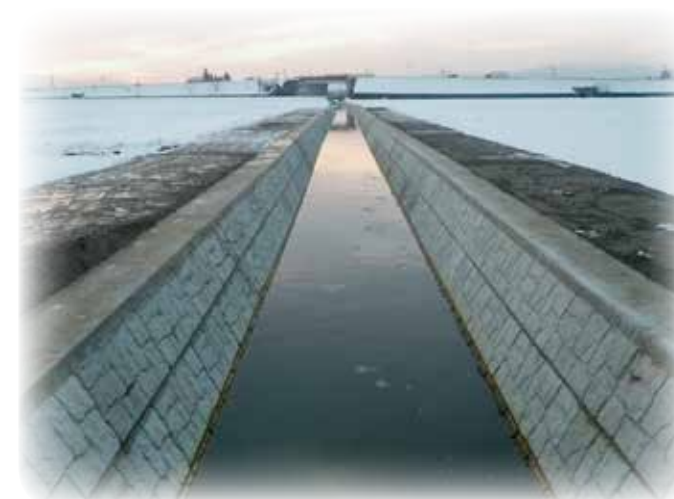
発注者：置賜総合支庁（山形県） 現場名：平成25年度（明許）河川整備単独事業棒川護岸復旧工事
