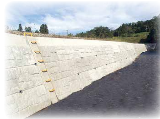
発注者：仙台市役所 現場名：河川芋沢川等河川災害復旧工事
