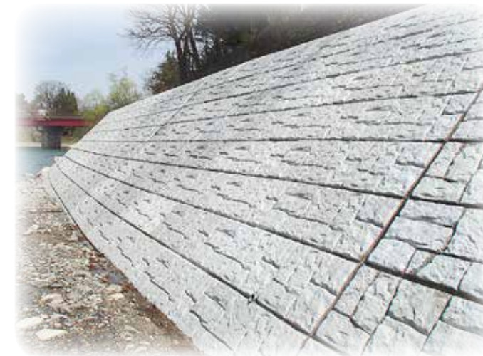
発注者：山形県庁 現場名：平成26年度河川整備単独事業横川護岸工事
