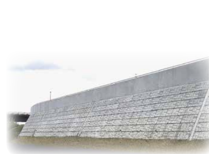
発注者：下館河川国道事務所（茨城県） 現場名：平成29年鬼怒川右岸向下築堤工事
