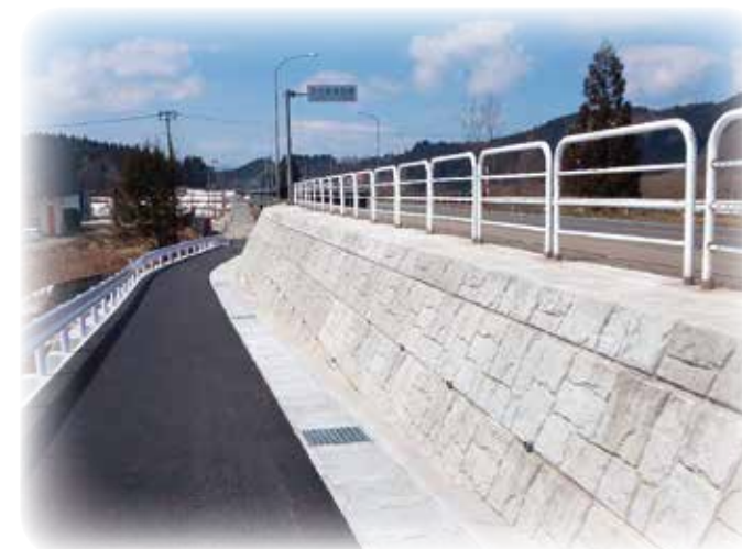
発注者：山形河川国道事務所 現場名：平成26年度新庄国道管内交通安全施設整備工事
