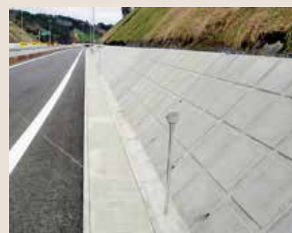
登米志津川道路(宮城県登米市)
