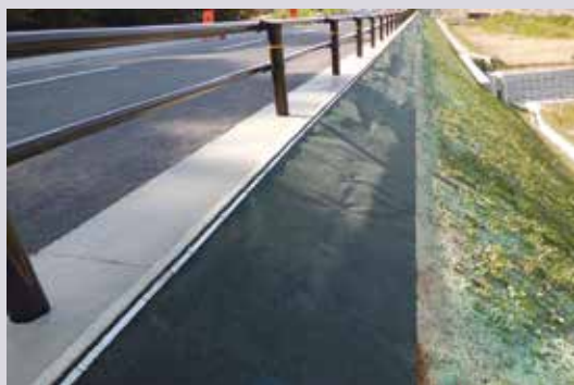
国道107号（岩手県奥州市）
